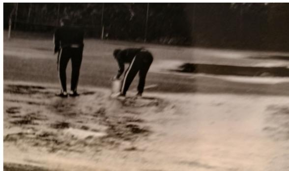
*Zustand der Plätze vor der Sanierung nach starken Niederschlägen. Die „Entwässerung“ erfolgte mit Decken und Handtüchern. Anschließend wurde Ziegelmehl aufgetragen um Vertiefungen zu glätten und die Plätze spielfähig zu machen.*
