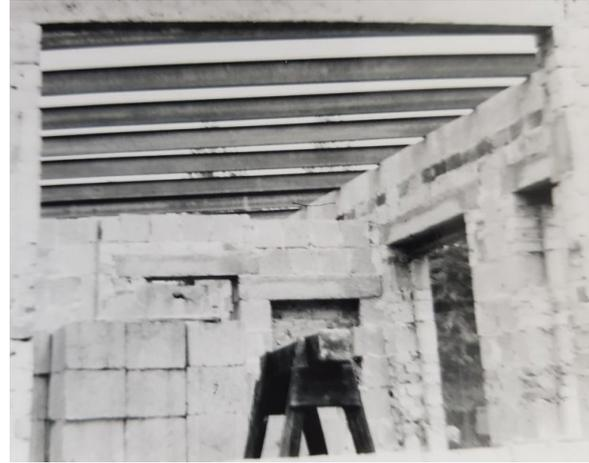
*Stahlträger wurden mit Muskelkraft auf die Außenmauern gehoben*
