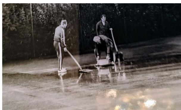
*Mit Schaufeln wurde das Wasser in Schüsseln vom Platz entfernt. Auch kamen Meißel zum Einsatz mit denen die Deckschicht bis zum Packlager durchgeschlagen wurde, um das Eindringen des Wassers zu beschleunigen.*
